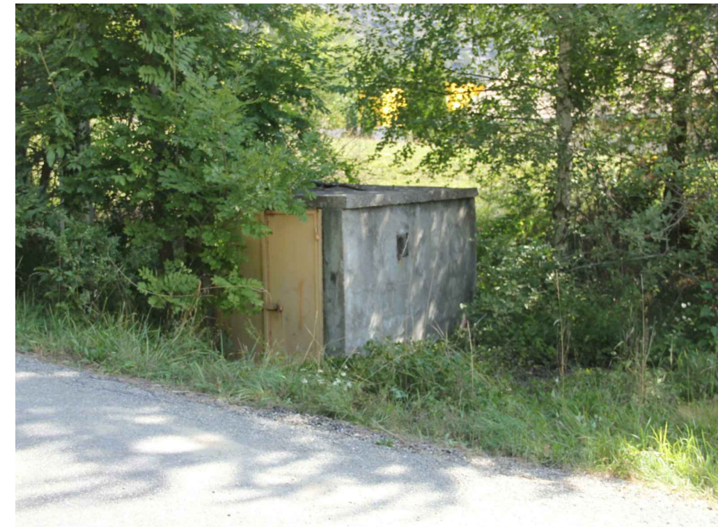
Vue extérieur du local du surpresseur
