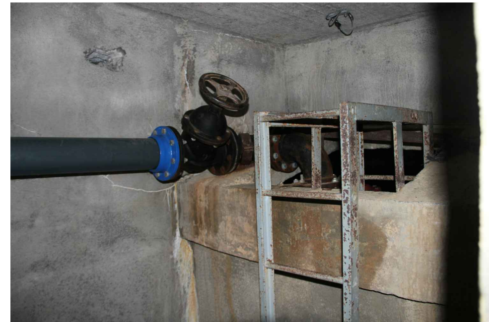
Arrivée du réservoir de Gabelle dans le réservoir
