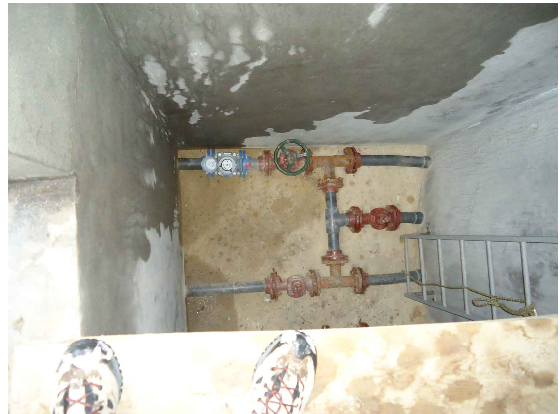
Vue intérieure du réservoir
